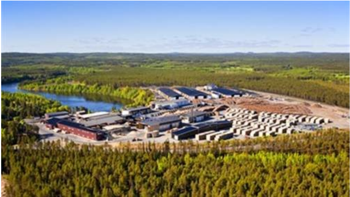
Figur 5 Stenvalls anläggning i Sikfors. Produktionstakten idag är 170 000 m 3 utsågad trävara.
